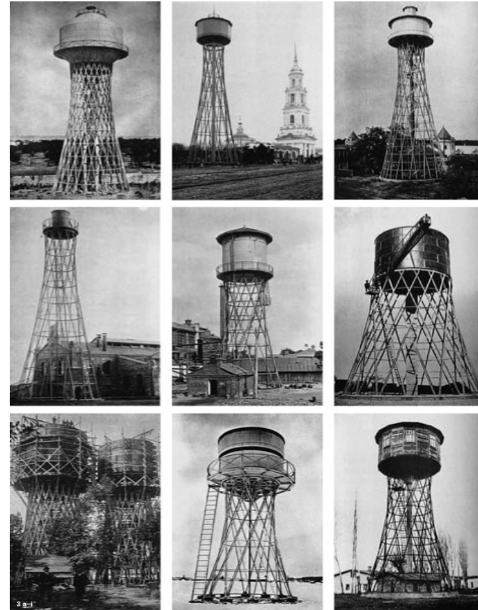
Hyperbolische Wassertürme in verschiedenen Ausführungen. Suchov variierte bei allen Standardisierungsbestrebungen stets Form und Proportionen der Bauwerke. Abgebildete Türme gebaut zwischen 1902 und 1915, Höhen (ohne Behälter) von 10 bis 36m, Fassungsvermögen zwischen 60000 und 600000 l (Bilder: Archiv Akademie der Wissenschaften, Moskau, aus Anm. 1)
